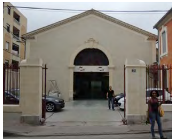
Réutilisation de hangar
