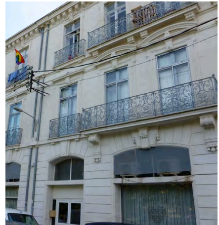
La mise en place de doubles fenêtres au nu extérieur nuit à l'harmonie d'origine
