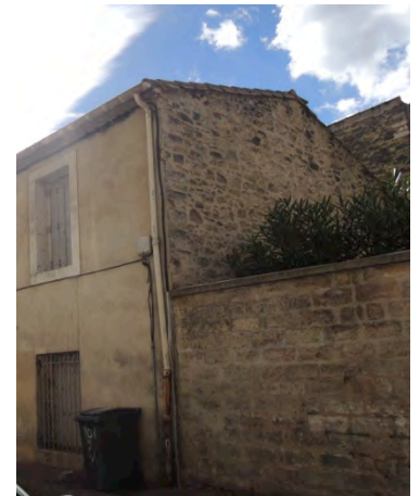
La mise en place d'une ITE sur certains murs pignons est parfois envisageable selon la modénature et la possibilité de faire disparaître les rives techniques latérales et hautes
