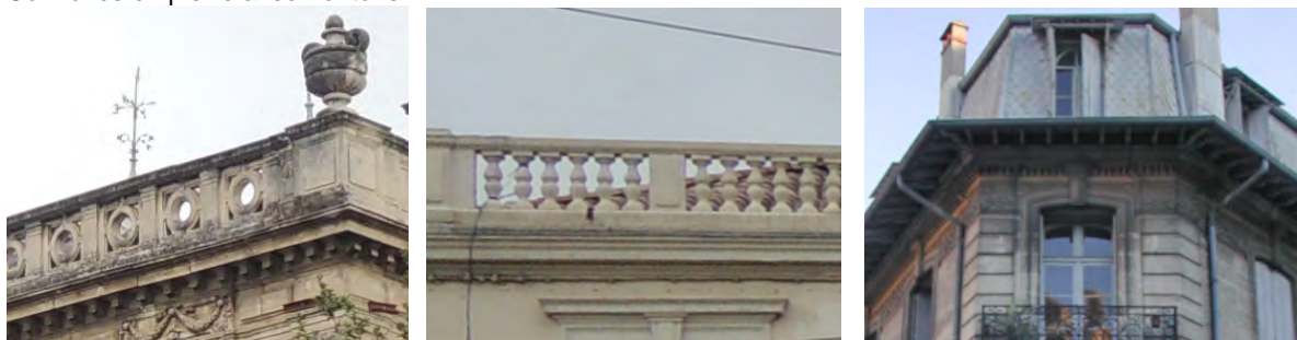
Corniches en pierre de taille avec frontons
