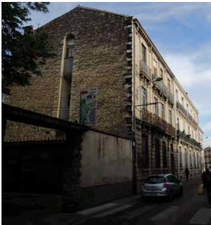
La mise en place d'une ITE sur certains murs pignons est parfois envisageable selon la modénature et la possibilité de faire disparaître les rives techniques latérales et hautes
