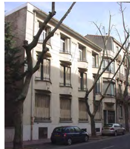
Architectes L. et R. Carlier
